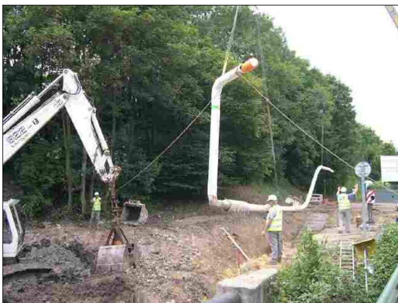
Illustration d'une baïonnette en cours de pose
